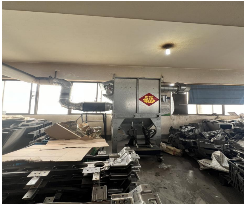
切割废气处理设施 (脉冲除尘+30 米高 FQ-1 排气筒)
