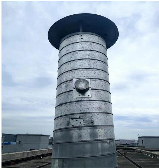
注塑废气处理设施（两级活性炭吸附装置+25米高排气筒（FQ-01））
