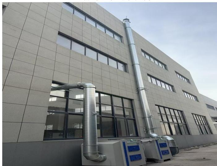
模压废气处理设施（两级活性炭吸附装置+15米高排气筒（FQ-05）
