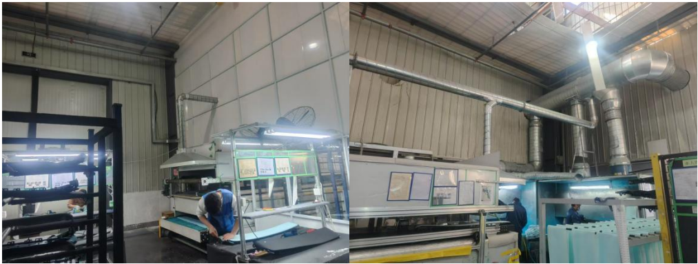
车间一水基型胶粘剂喷胶台废气收集集气罩
